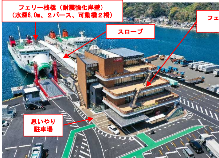
八幡浜港フェリーターミナル全景
