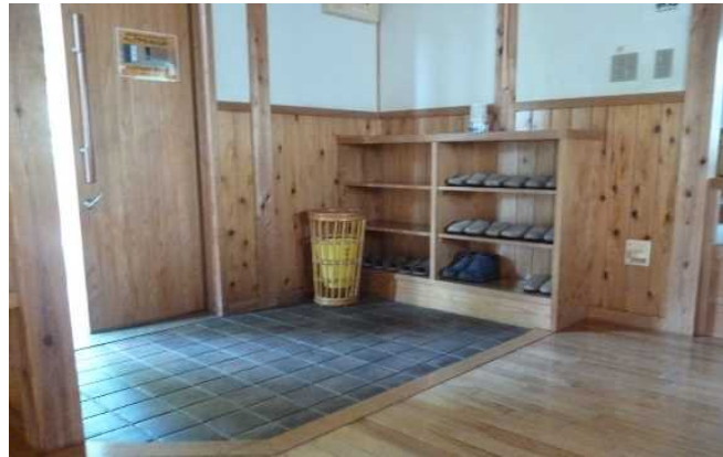
屋外から段差無く進入できる玄関
