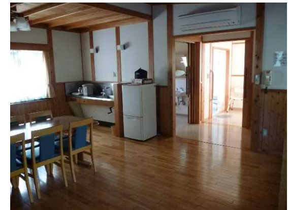
段差の無い屋内と 昇降式流し台
