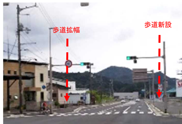
改良後の状況
