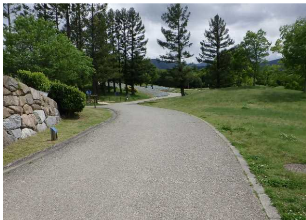
緩勾配で車いす同士の離合にも配慮した通路幅の確保
