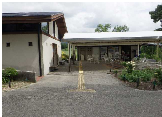
段差なしで立ち寄れる園内トイレ
