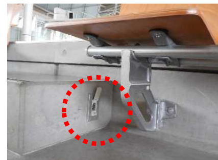
集団補聴設備の設置
