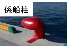
松山港：更新された「防舷材」「係船柱」(H30年度完成)
