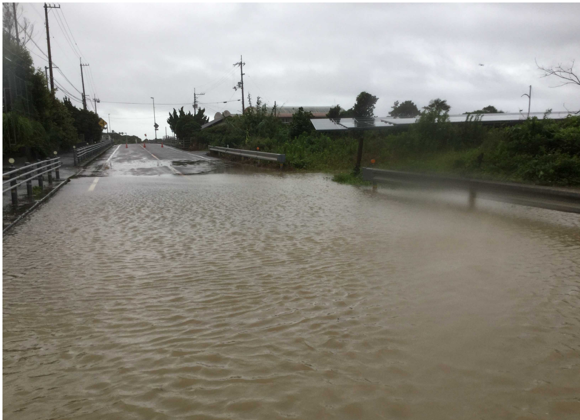
令和元年7月 冠水
