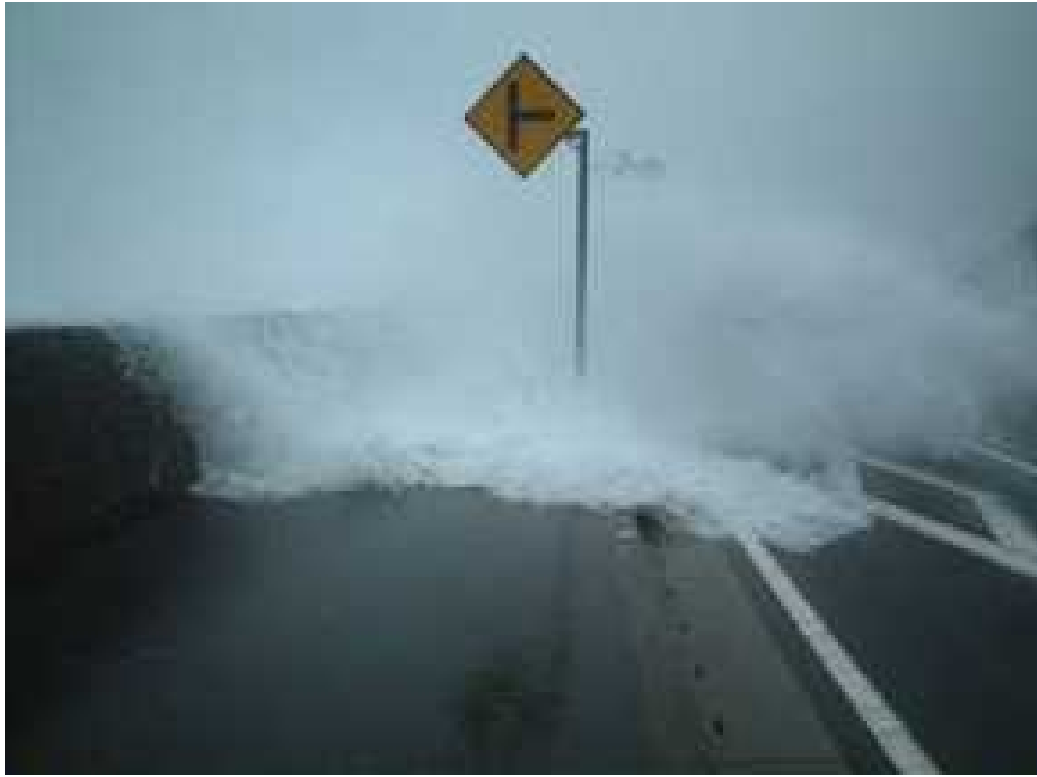
平成16年9月 越波(国道55号 室戸市)
