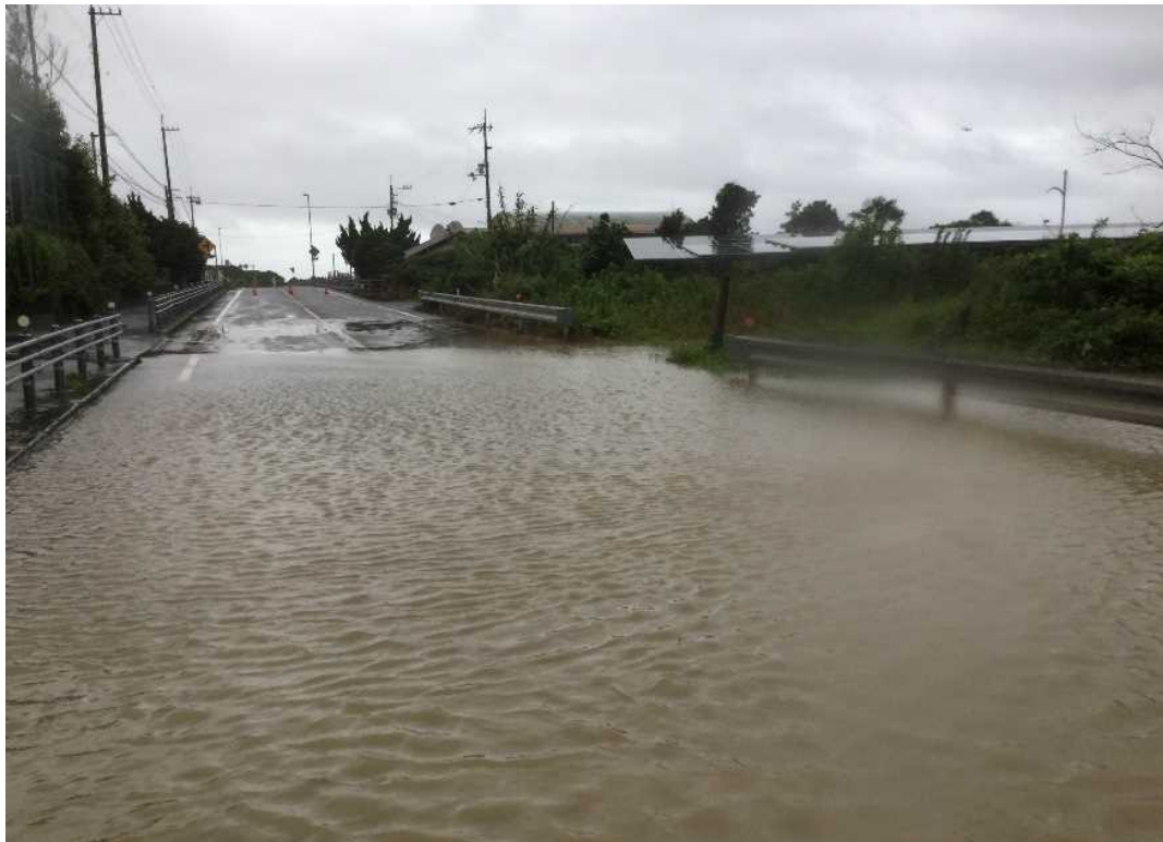
令和元年7月 冠水(国道55号 室戸市)
