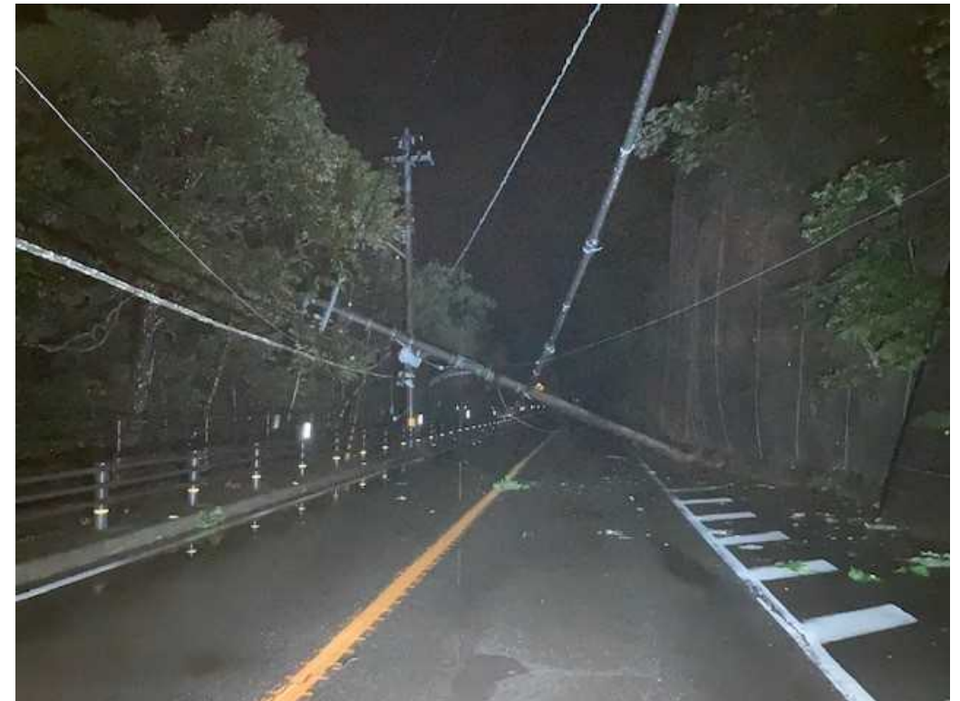
令和6年6月 電柱倒壊(国道32号 三好市)
