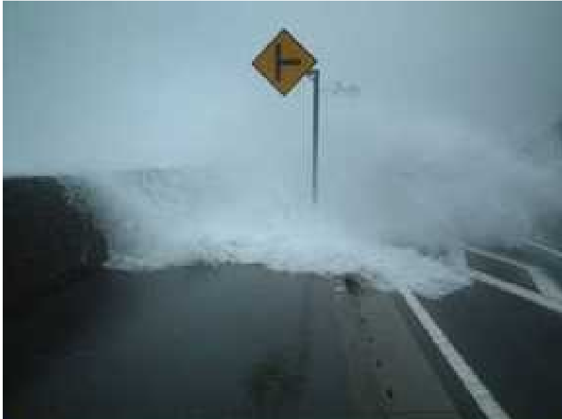
平成16年9月 越波(国道55号 室戸市)
