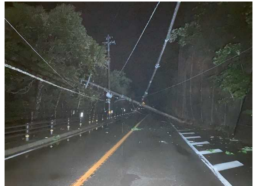
令和6年6月 電柱倒壊(国道32号 三好市)
