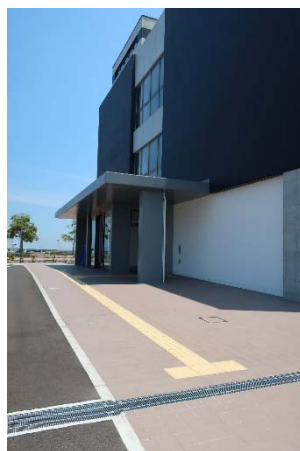
アプローチ (段差無し、点字表示)
