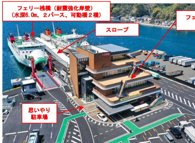
八幡浜港フェリーターミナル全景
