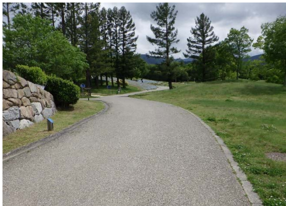
緩勾配で車いす同士の離合にも配慮した通路幅の確保
