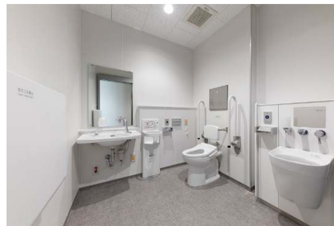
バリアフリートイレ (手摺、オストメイト、おむつ交換台)
