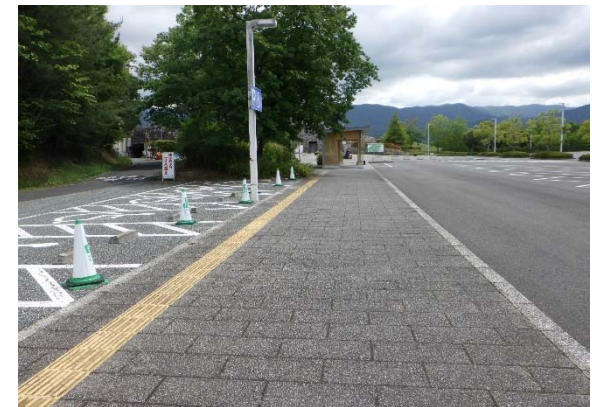
肢体不自由者用駐車場と段差の無い園内通路
