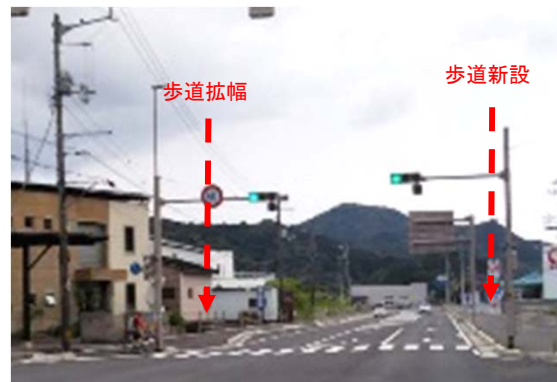
改良後の状況
