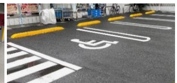
狭小敷地等での 車椅子使用者用駐車施設 の確保・ダブルライン活用による駐車場全体の緩やかなバリアフリー化のイメージ
