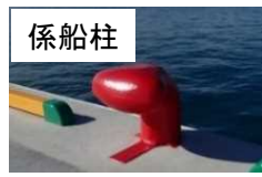
松山港：更新された「防舷材」「係船柱」(H30年度完成)
