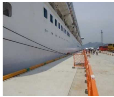
松山港：更新された「防舷材」「係船柱」(H30年度完成)
