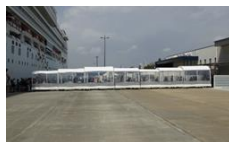
屋根付き通路 (鹿児島港)
