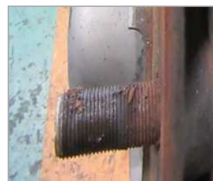
ボルトに著しいさびや汚れの付着
