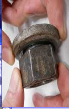
劣化したナットの点検・交換
