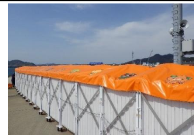
屋根付き通路 (松山港)
