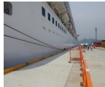
松山港：更新された「防舷材」「係船柱」(H30年度完成)
