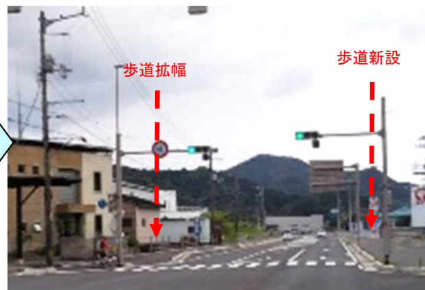
改良後の状況
