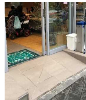
スロープの設置
