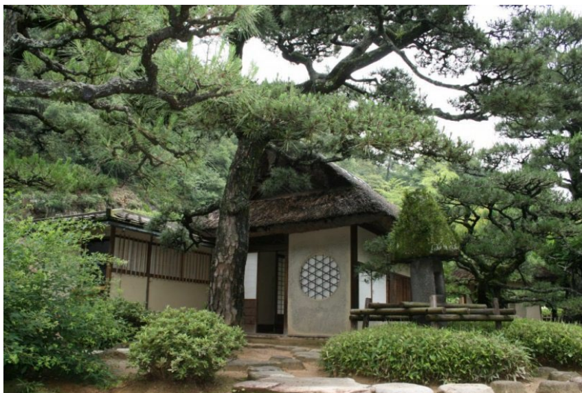
写真 2-3-6 旧日暮亭 外観
