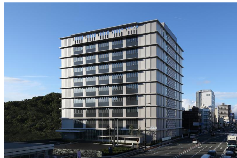
庁舎外観 (南東面 エントランス側)
