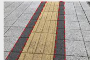
視覚障害者誘導用ブロックの輝度比を確保した事例
