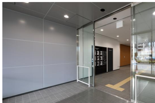
玄関 (自動扉・点字ブロック誘導)
