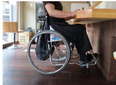
ローカウンターの設置
