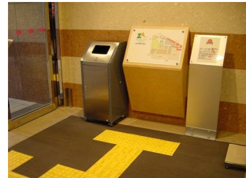
点字ブロック、点字案内板の設置
