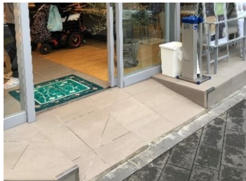
スロープの設置
