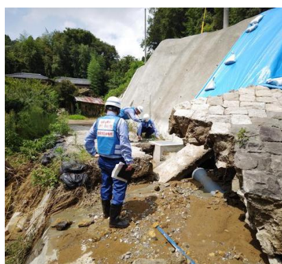
道路法面の被災状況調査 (千葉市)
