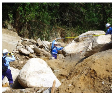
土砂災害被害状況の調査
