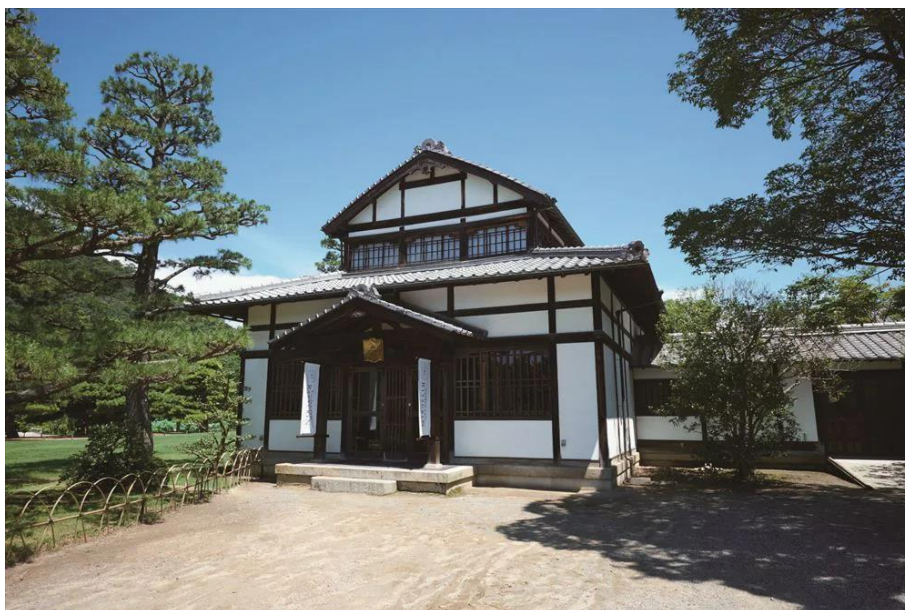
写真 2-3-2 商工奨励館西館 外観 ガーデンカフェ栗林 入口
