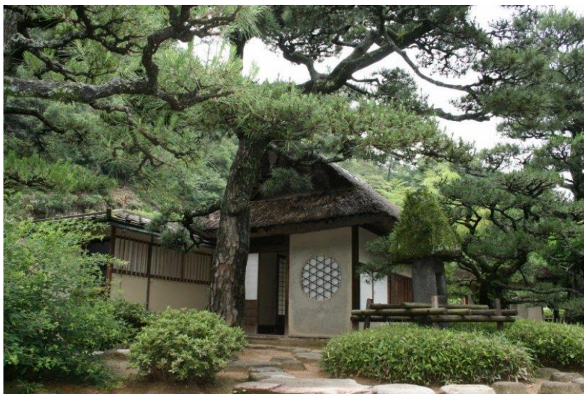
写真 2-3-6 旧日暮亭 外観
