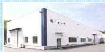
倒壊した工場・施設等の復旧支援
