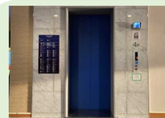
船内エレベーター
