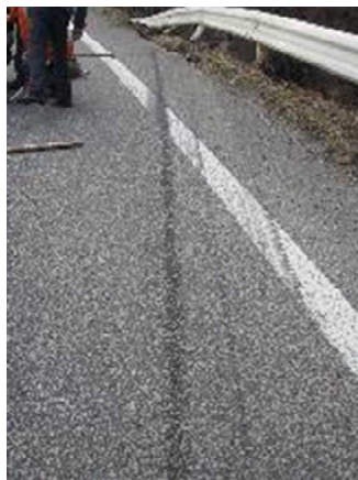
写真 22 路面のタイヤ痕
