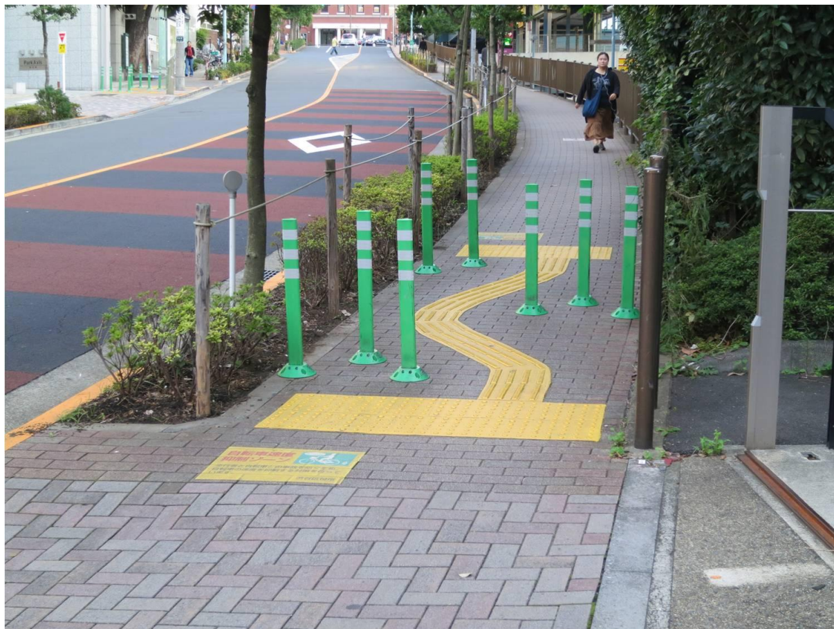
図1 歩道上のバリカー（東京都渋谷区）歩道上の自転車の速度を抑えるのは難しい
