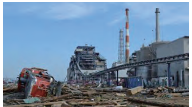
写真 2.9.2 壊滅した石巻港駅
