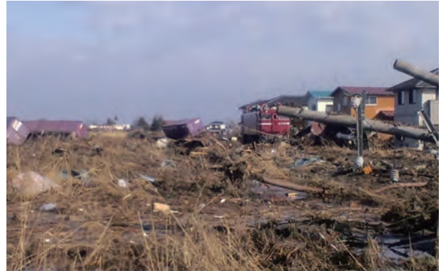
写真 2.9.1 津波で脱線した第92列車
