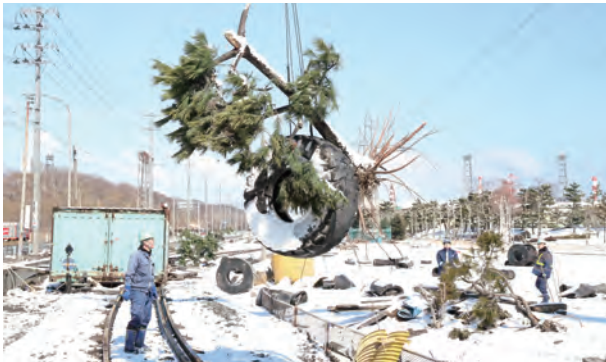
写真 2.10.4 北沼駅構内の瓦礫撤去
