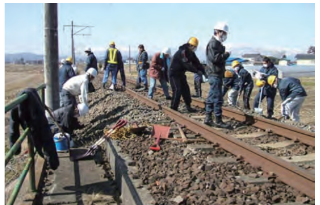
写真 2.6.5 復旧作業（二井田駅～新田駅間）
