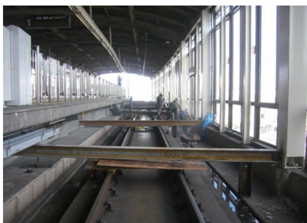
写真 2.5.5 八乙女駅の応急処置状況
