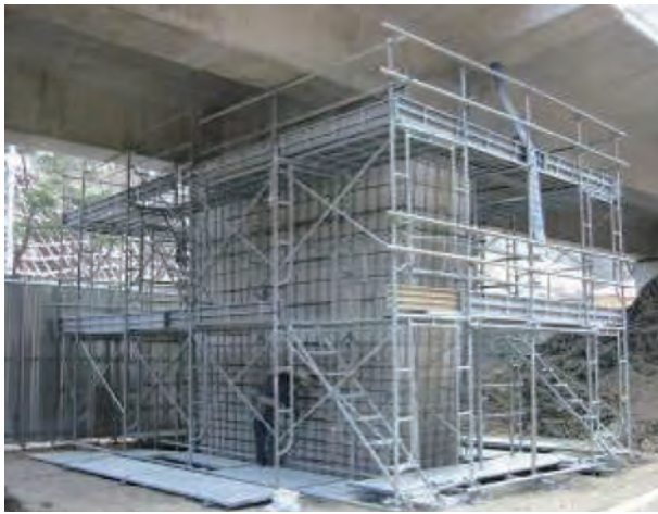
写真 2.5.1 耐震補強工事
