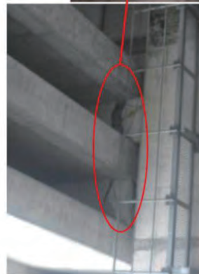
②仙台川橋梁
