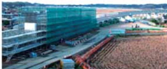
野蒜地区の鉄道施設工事(仙石線) H25.11.28
