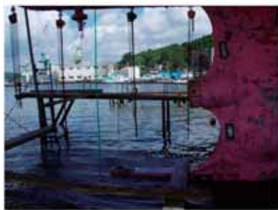
地盤沈下の影響で船尾が水に浸かる 船台（気仙沼市）H24.10.19
