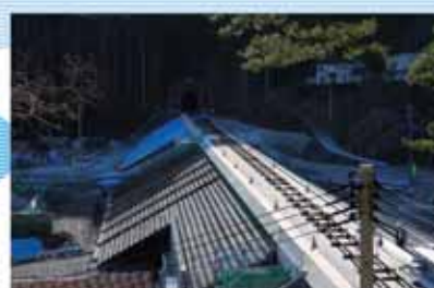
復旧工事の進む北リアス線(鳥越駅付近)
