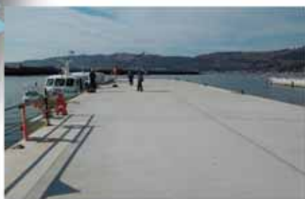
離島・金華山2号岸壁復旧状況 (石巻市金華山) H26.1.24
