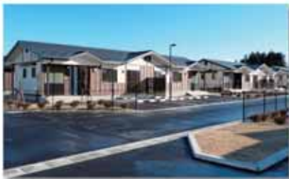
野田村(野田地区)に整備された 災害公営住宅
