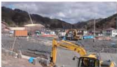
大槌町(大ヶ口地区)で整備中の 災害公営住宅
