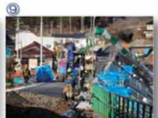
⑨ 三陸鉄道南リアス線南嶺駅復旧工事
