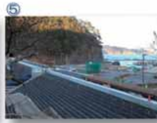
⑤ 三陸鉄道北リアス線島越駅復旧工事
