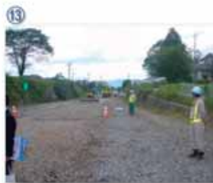
⑬ JR気仙沼線陸前階上駅付近BRT工事
