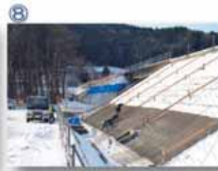
⑧ 三陸鉄道南リアス線南嶺駅付近復旧工事
