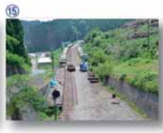
⑮ JR気仙沼線歌津駅付近BRT工事
