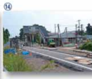
⑭ JR気仙沼線陸前階上駅BRT工事
