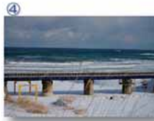
④ JR八戸線大浜川橋梁復旧工事
