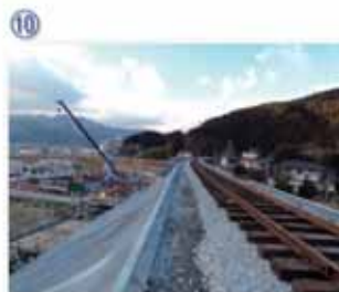
⑩ 三陸鉄道南リアス線陸前赤崎駅付近復旧工事
