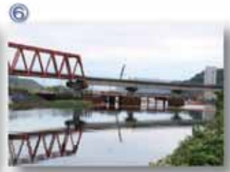
⑥ 三陸鉄道南リアス線大渡川復旧工事
