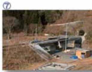
⑦ 三陸鉄道南リアス線荒川橋梁復旧工事
