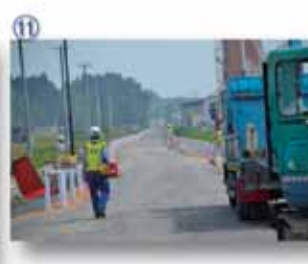
⑪ JR気仙沼線最知駅付近BRT工事
