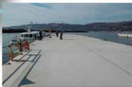
離島・金華山2号岸壁復旧状況(石巻市金華山) H26.1.24
