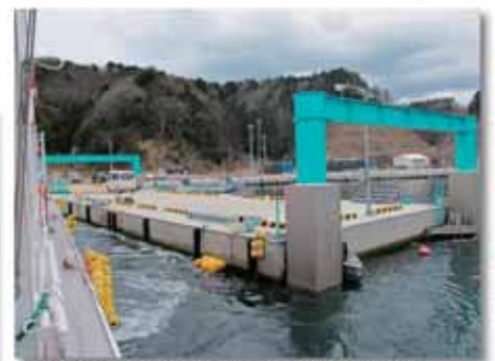
「女川～江島航路」出島新浮棧橋(女川町出島漁港) H26.2.8
