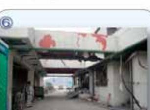
宮古港湾合庁：2階天井近くまで浸水。岩手運輸支局宮古庁舎が浸水被害を受けた。
