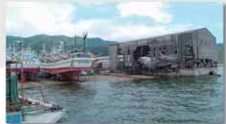
地盤沈下した船台と全壊した工場 (岩手県大船渡市)
