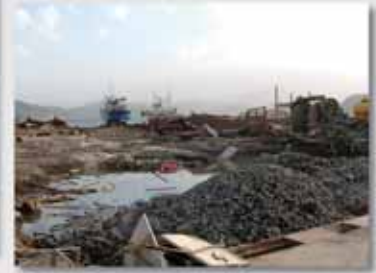
船台を残し工場が全壊した造船所 (岩手県大槌町)
