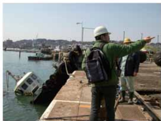
東北運輸局による塩竈市内造船所の現地調査 H23.3.13
