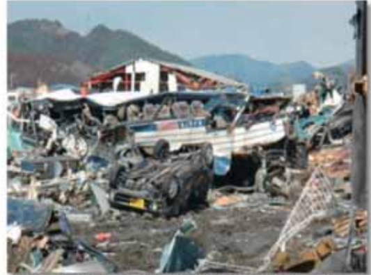
津波を受けた自動車整備工場(大船渡市)H23.3
