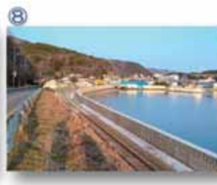
⑧ JR石巻線沢田駅～宿浦駅間（復旧工事完了）
