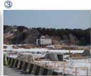
③ 復旧工事が進む宮古市田老地区。たろう観光ホテルは震災遺構として保存される
