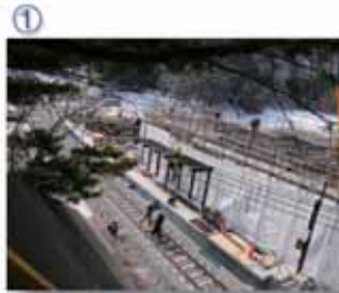
① 26/4/6の全面再開に向け復旧工事が進む三陸鉄道北リアス線島越駅
