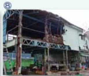
⑧ 宮古漁業協同組合造船工場
