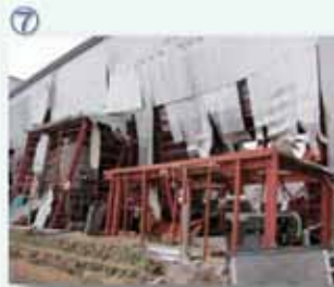
⑦ 北日本造船株久慈工場
