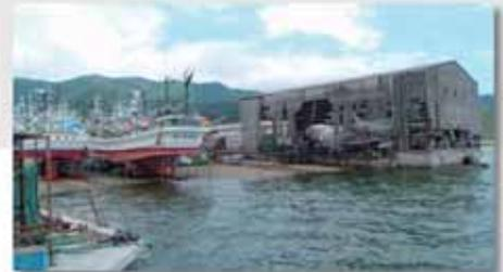
地盤沈下した船台と全壊した工場
