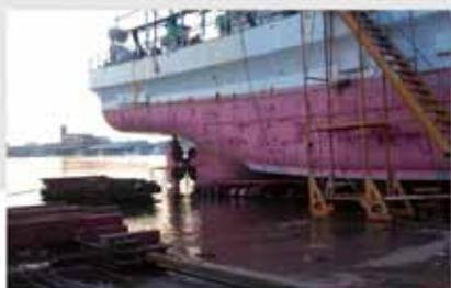
地盤沈下により上架能力が低下した造船所(いわき市)
