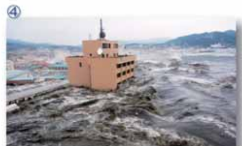
④ 宮城県気仙沼合同庁舎：津波が2階の天井裏まで押し寄せた。この時、一般市民も含め、約290名避難していた。
