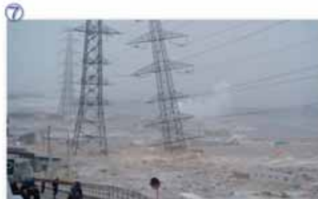
⑦ イオン多賀城店：仙台港から直線距離で約1km先にあるイオン多賀城店まで津波が押し寄せ、駐車中の多くの車両が流れた。
