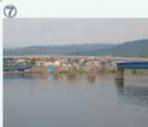
⑦ JR山田線関伊川橋梁
