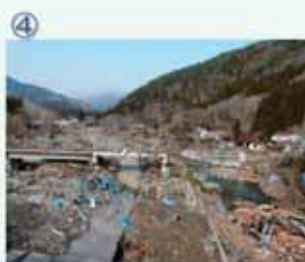
④ 三陸鉄道南リアス線荒川橋梁
