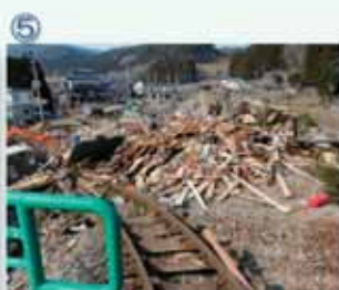
⑤ 三陸鉄道南リアス線甫嶺駅
