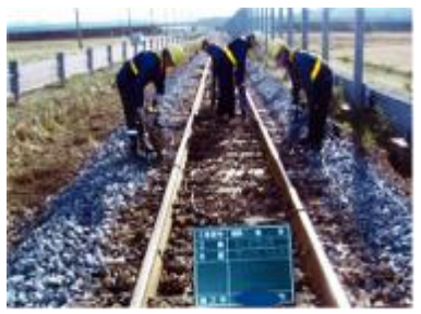
レールの修繕
