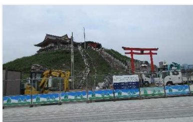
燕嶋神社（工事中）
