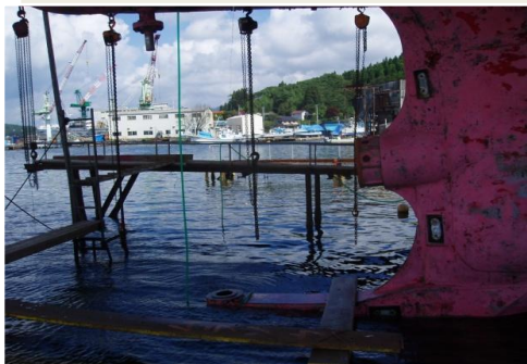
震災による地盤沈下(気仙沼市)
