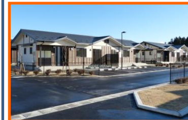
整備が完了した災害公営住宅
