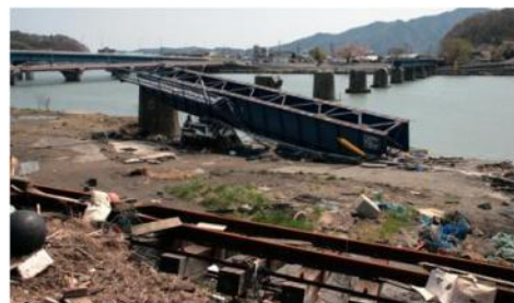
第34閉伊川橋りょう 橋桁流出 (宮古～磯鶏間)
