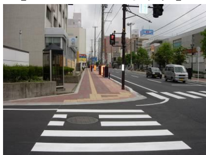
段差解消された歩道（秋田環状線）
