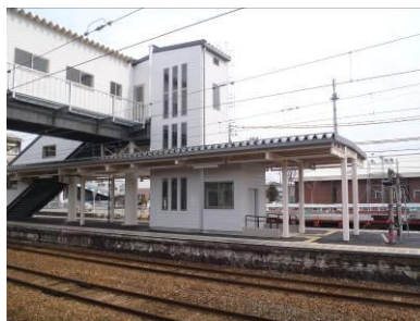
エレベーターが設置されたご線橋（土崎駅）
