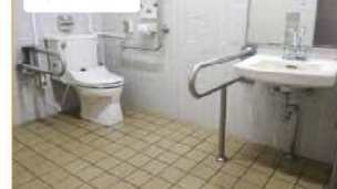
手すり:左側固定、右側可動
