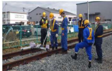
仕上りトラックマスター/軌道検測
