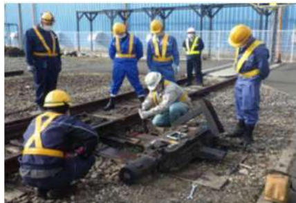
分岐器調整/軌道検測
