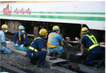
車両脱線復旧
