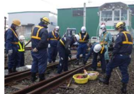
分岐器解体組立て
