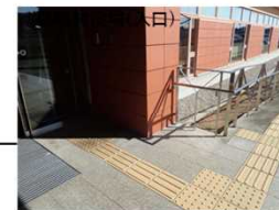
< 泉崎村役場(入口) > 誘導ブロックが玄関までしか設置されていない
