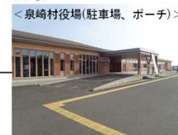
< 泉崎村役場(駐車場、ポーチ) > 誘導ブロックが大きく迂回している
