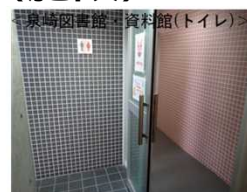
< 泉崎図書館・資料館(トイレ) > バリアフリートイレ未設置
