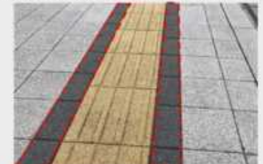
視覚障害者誘導用ブロックの硬度比を確保した事例
