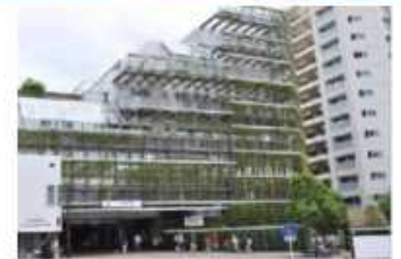
大岡山駅(駅外観)
