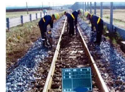
レールの修繕
