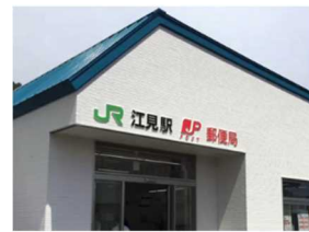
駅舎の 新改築・移設
