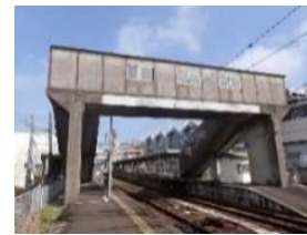
既存施設の 撤去
